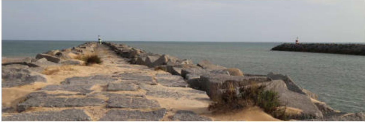
Figura 11.1 – Alvor. Vista dos molhes da embocadura
