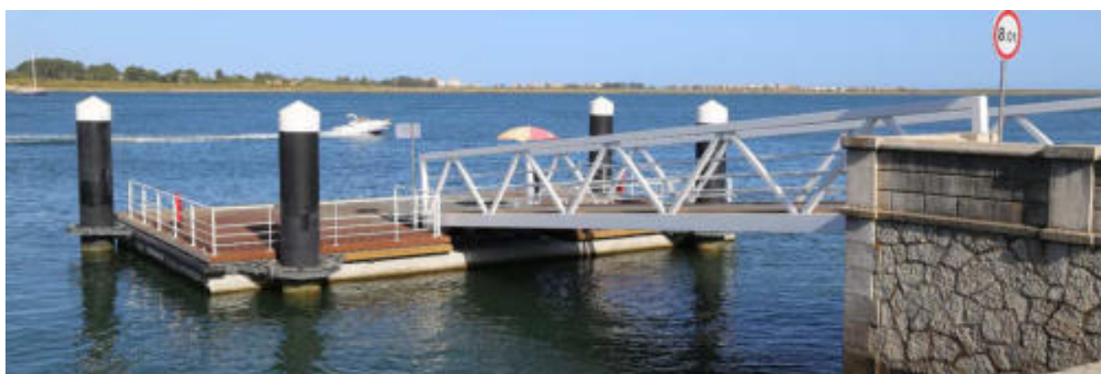
Figura 21.2 – Vila Real de Sto. António. Vista do novo cais transfronteiriço
