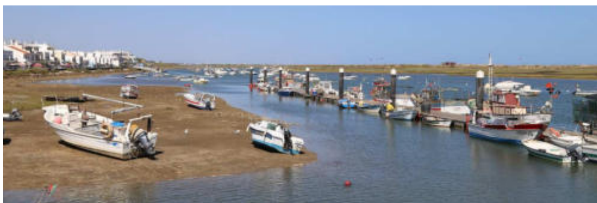
Figura 20.2 – Cabanas. Vista do cais flutuante
