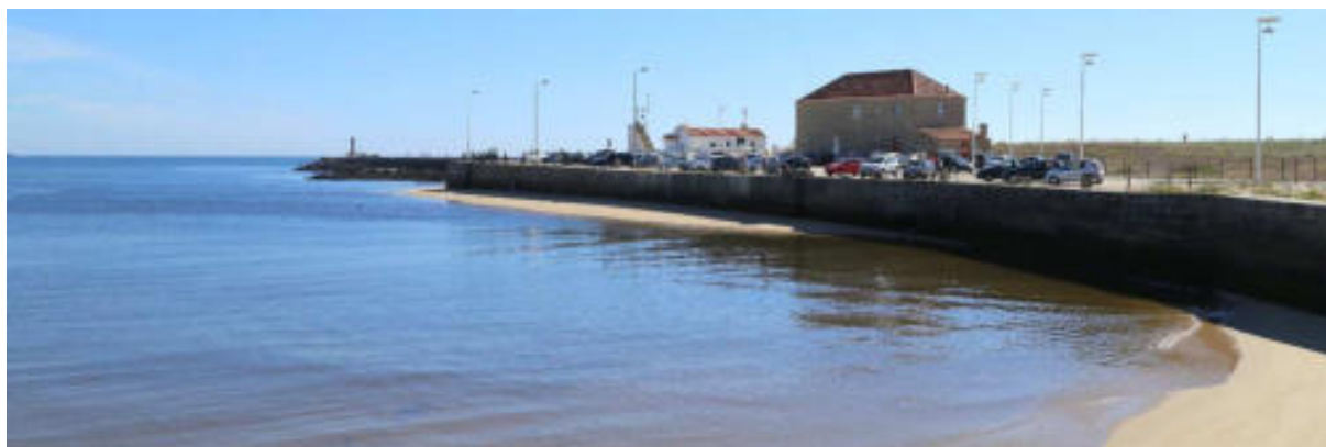
Figura 5.1 – Vila do Conde. Vista do molhe N da embocadura
