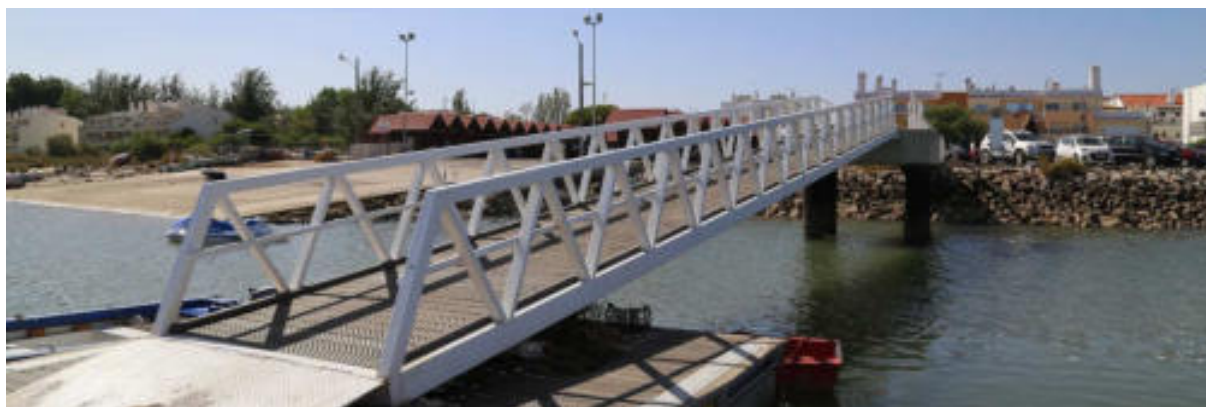
Figura 20.1 – Cabanas. Vista do acesso ao cais flutuante e da rampa varadouro
