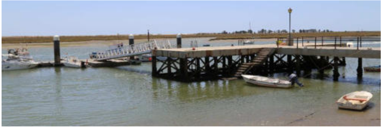
Figura 18.1 – Santa Luzia. Vista da ponte cais
