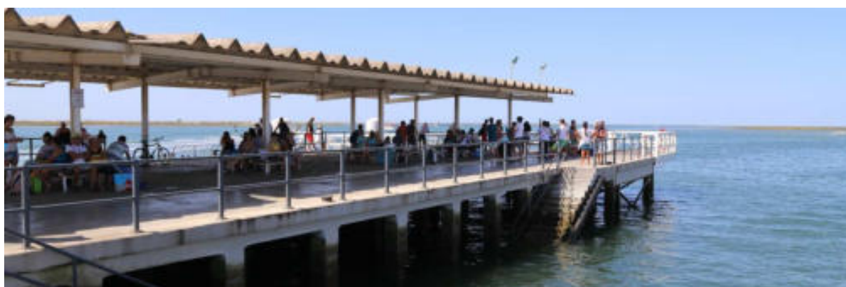
Figura 16.2 – Olhão. Vista do terminal de passageiros
