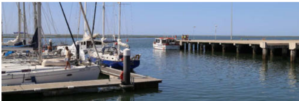
Figura 16.1 – Olhão. Vista do Porto de Recreio e do cais fundado em estacas
