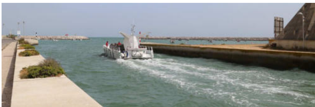
Figura 13.2 – Albufeira. Vista do canal de acesso à Marina
