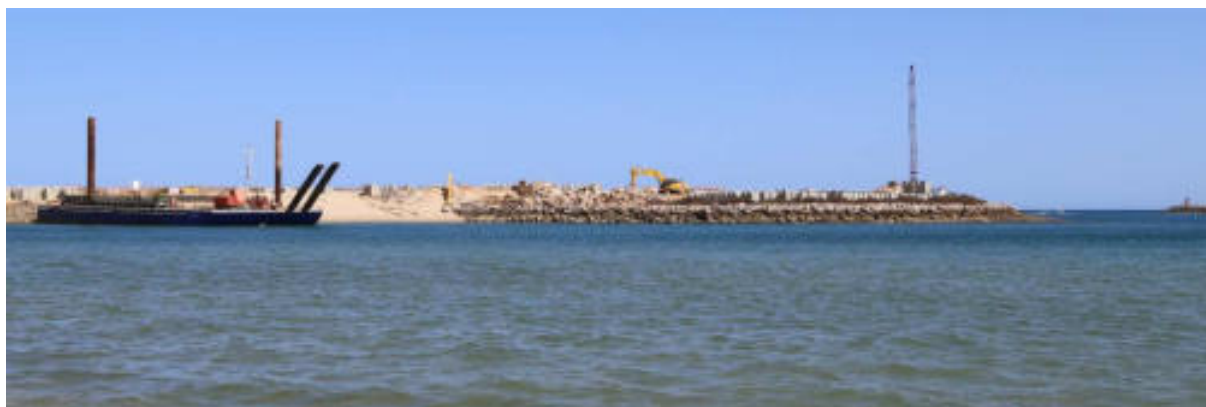
Figura 19.1 – Tavira. Vista do molhe E da barra (em obras)
