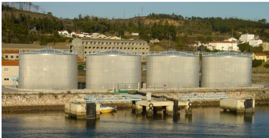
Figura 5 – Terminal de Receção de Produtos Betuminosos, do Porto da Figueira da Foz.
