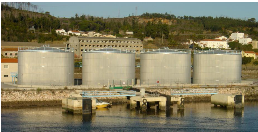
Figura 5 – Terminal de Receção de Produtos Betuminosos, do Porto da Figueira da Foz.
