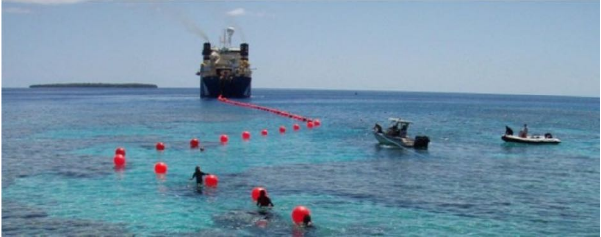
Instalação de boias para colocar o cabo na praia.
