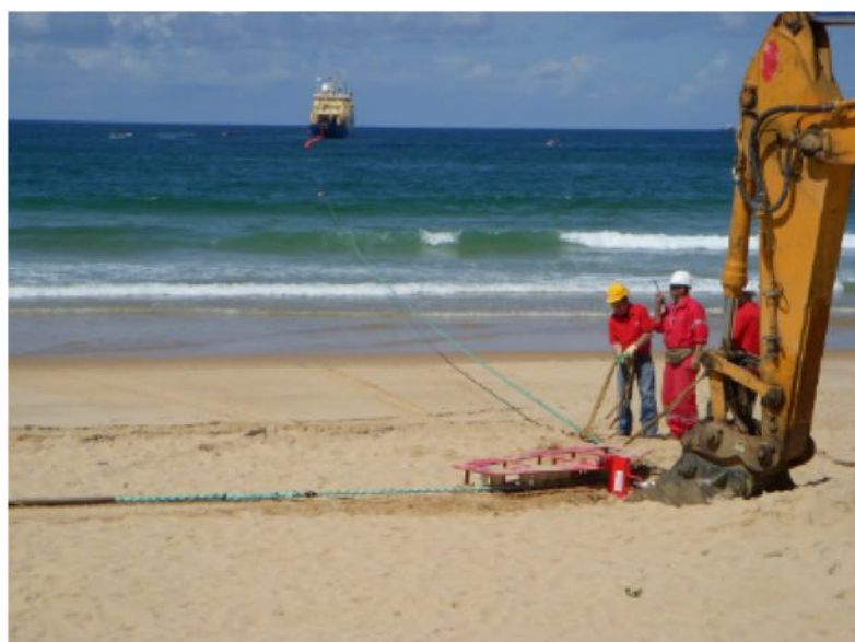
Escavadora e quadrante utilizados em operações de desembarque
