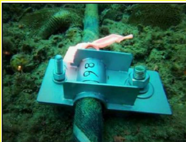
Exemplo da instalação do grampo do cabo (uma âncora de haste).
