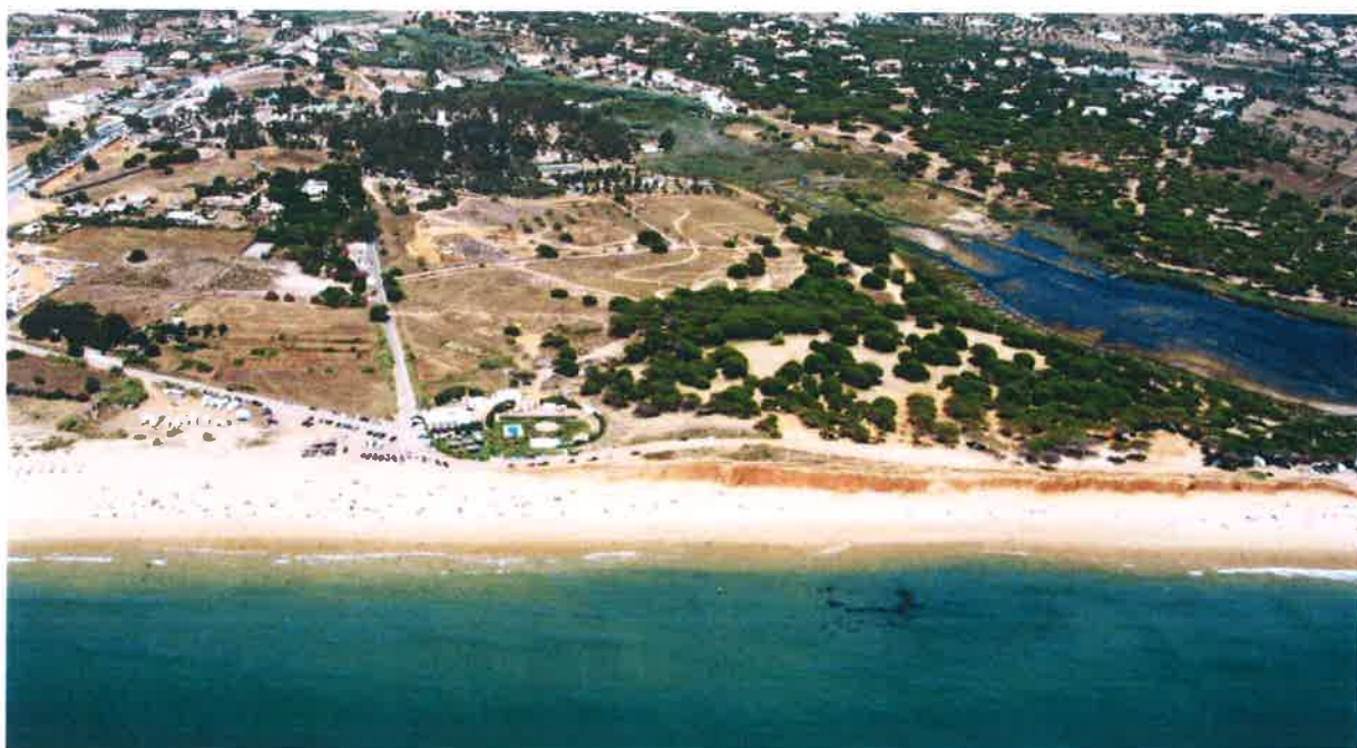
Figura 6 - A praia e arriba do Forte Novo, em 2 agosto de 2006. Note-se, na zona imersa, as ruínas do forte, destruído, no final da década de 1970, em consequência do recuo da arriba. No lado direito da foto, o plano de água da lagoa costeira de Almagem.
