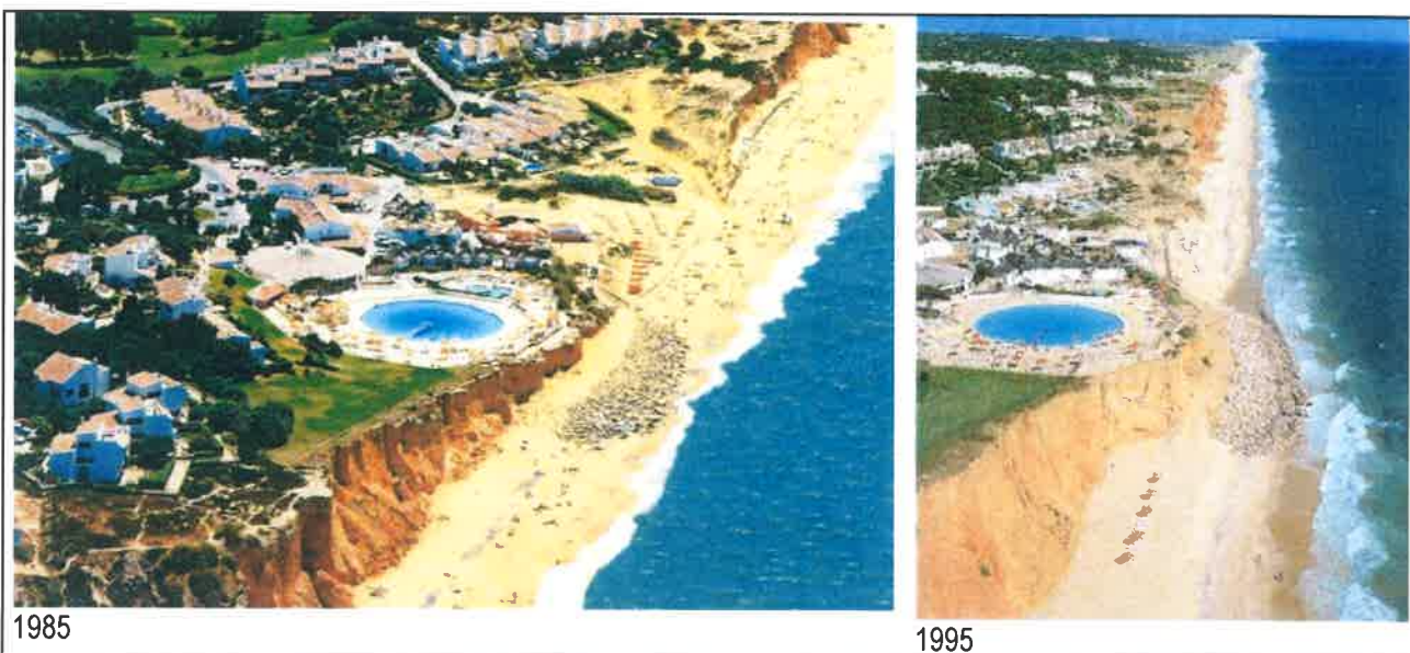
Figura 8 – O enrocamento da piscina de Vale do Lobo.
